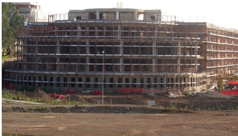
L'edificio del PRABB: in primo piano il lato semicircolare a nord
